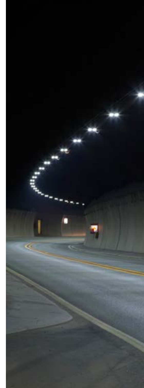
Tunnel de Skaun Norvège
