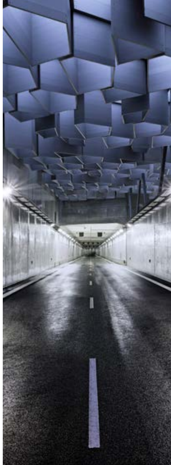
Tunnel du Nordhavn Danemark
